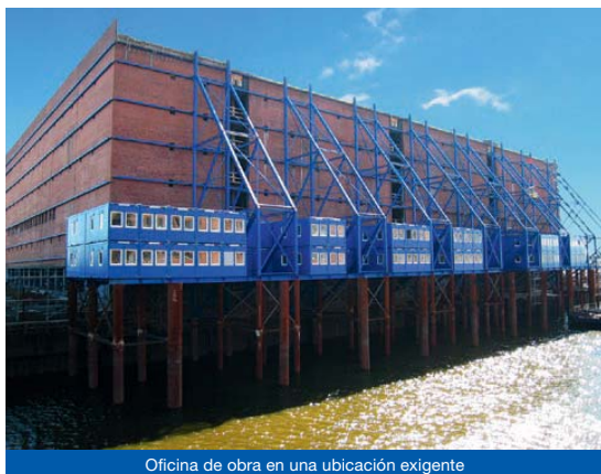
Oficina de obra en una ubicación exigente
