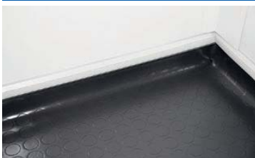
Suelo abotonado (con continuación en paredes)
