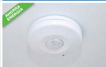
Sensor de movimiento para la luz
