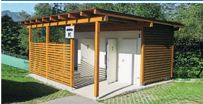
Cabina sanitaria de 20' como WC en aparcamiento
