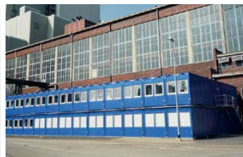
Alojamiento para trabajadores
